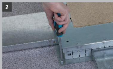
2 Вставить кабель-каналы и привинтить к полу
