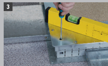
3 Отрегулировать с помощью винтов
