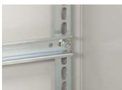
0 367 84 с клипса-гайками 0 364 42 + винты 0 367 75
